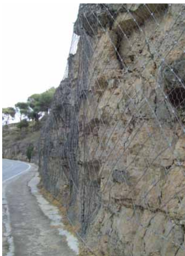
Figura 17. Tratamiento con malla-talud efectuado en la Cuesta de Los Hoyos (Segovia) (Foto: Andrés Díez).
