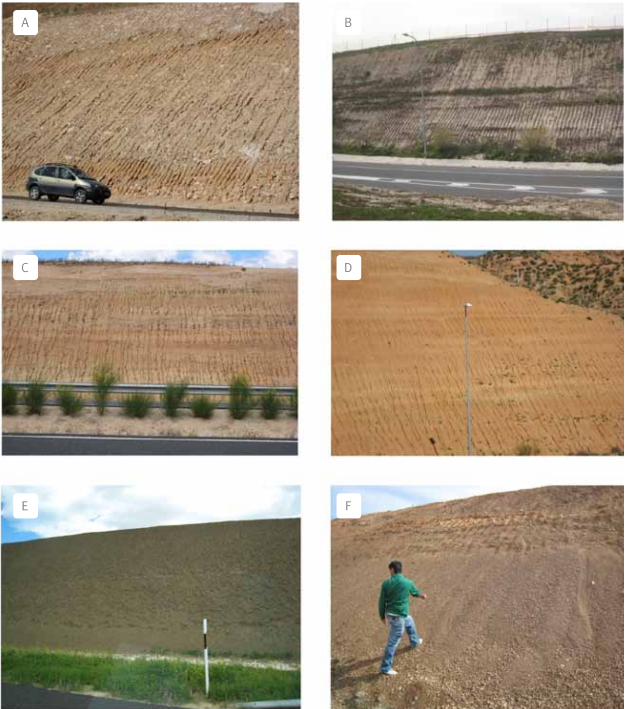
Figura 3. Morfologías que se desarrollan de manera más ‘típica’ sobre cada una de las litologías detríticas que caracterizan los desmontes de las infraestructuras lineales de la Cuenca de Madrid, bajo condiciones climáticas mediterráneas (en Barbero et al. , 2009a) (Fotos: J.F. Martín Duque).
