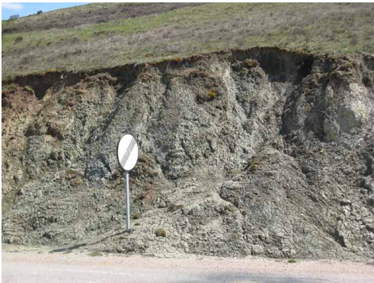
Figura 2. Flujos de barro ( mudflows ) en un pequeño desmonte de una carretera local. Los procesos geomorfológicos que se desarrollan en estos desmontes son similares a los que operan en otros ambientes continentales (por ejemplo zonas de montaña), pero tienen mucho menor tamaño (Foto: J.F. Martín Duque).
