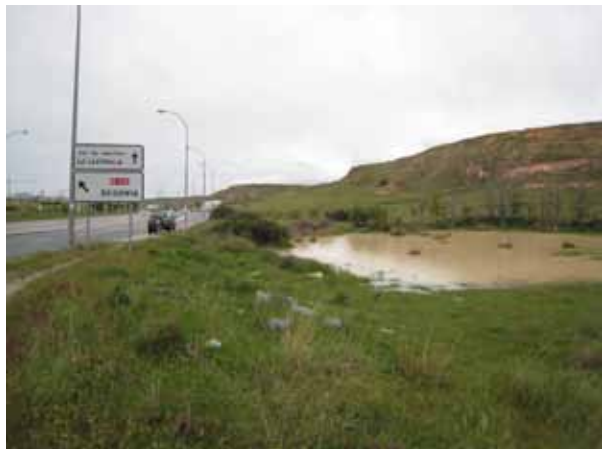
Figura 7. Ejemplo de encharcamiento ocasionado por el efecto 'barrera presa' que ejerce la carretera sobre el flujo hidrológico superficial y subterráneo procedente de la ladera de la derecha de la imagen (Foto: J.F. Martín Duque).
