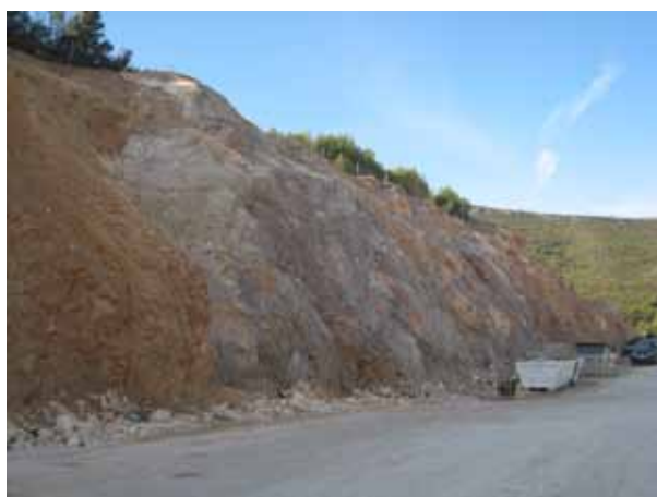
Figura 22. Aspecto de un talud Royal en construcción, en una autopista que atraviesa el macizo del Garraf (Cataluña). La Declaración de Impacto Ambiental de esta autopista puso como condición la construcción de este tipo de talud en esta zona. Nótese cómo las rocas de la izquierda de la imagen (rocas de falla, más erosionables) son remodeladas formando ya una pequeña depresión en el desmorte, alcanzando desde el principio la que será su más que previsible evolución, tal y como ocurre en las laderas ‘naturales’ del entorno (Foto: J.F. Martín Duque).
