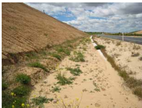
Figura 8. Acumulación de sedimentos procedentes de un desmonte, que prácticamente colmata una cuneta (Foto: J.F. Martín Duque).
