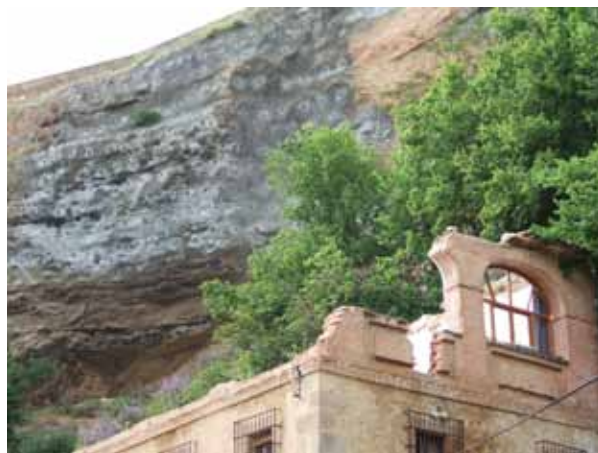
Figura 18. Detalle del bulonado y gunitado elegido como solución técnica para la fijación de la placa de roca contigua a la zona desprendida (Foto: Andrés Díez).
