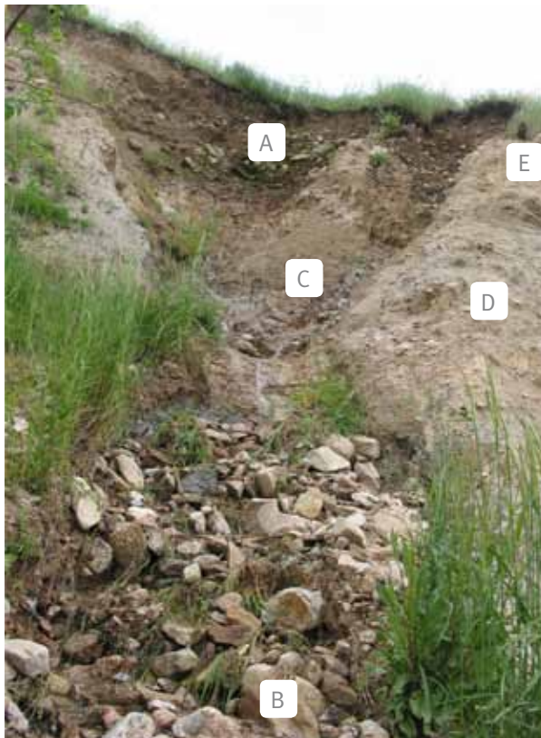
Figura 4. Cabecera de deslizamiento (a) y derrubios movilizados (b) en un desmonte de carretera, a favor de una surgencia de agua (c) producida en el contacto entre una roca impermeable (d) y unos cantos y bloques permeables (e), correspondientes a un depósito de abanico aluvial (Foto: J.F. Martín Duque).
