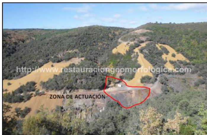
Vista general de la escombrera objeto de remodelado, obstruyendo una pequeña cuenca hidrográfica. Las zonas de tonos ocre corresponden a labores de restauración edafopaisajística realizadas en escombreras del entorno, llevadas a cabo por el grupo de Restauración Ambiental de la Fundación Ciudad de la Energía (CIUDEN), siguiendo la metodología descrita en García y Cantó (2010).
