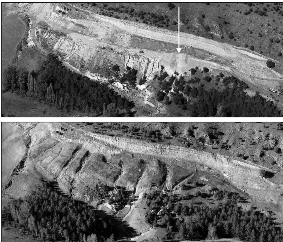
Figura 1. (Superior) inicio del proceso de restauración (octubre de 2008); la flecha indica el inicio de construcción de una de las vaguadas. (Inferior) situación posterior a la restauración (diciembre de 2008). Fotos Paisajes Españoles SA
